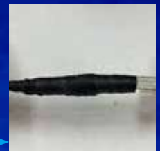
接続部分に融着テープを巻き付ける
