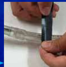
接続部分に融着テープを巻き付ける
